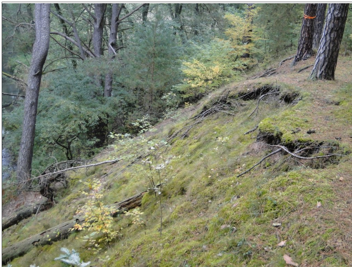
skarpa główna osuwiska z widocznymi, świeżymi obrywami.
