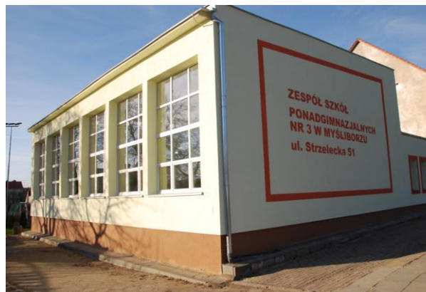
Sala gimnastyczna- po termomodernizacji.
