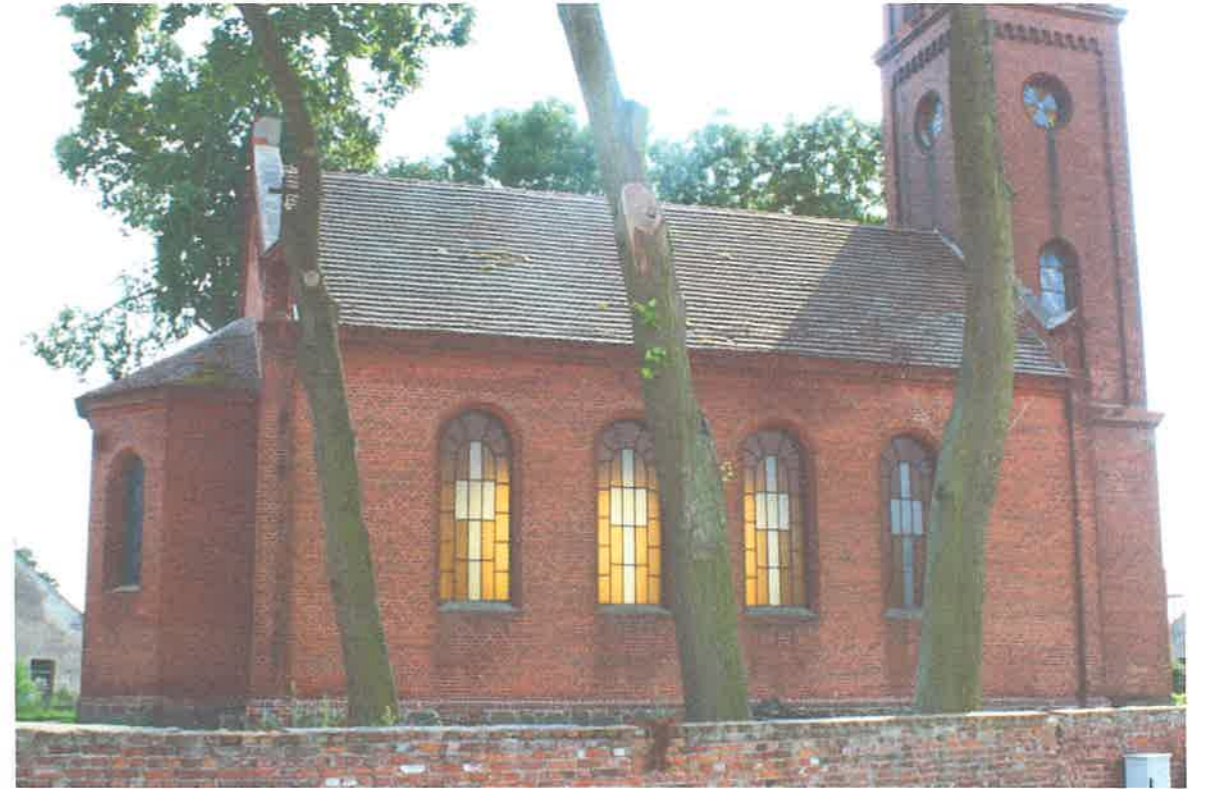
Fot. 7 Elewacja północna.
