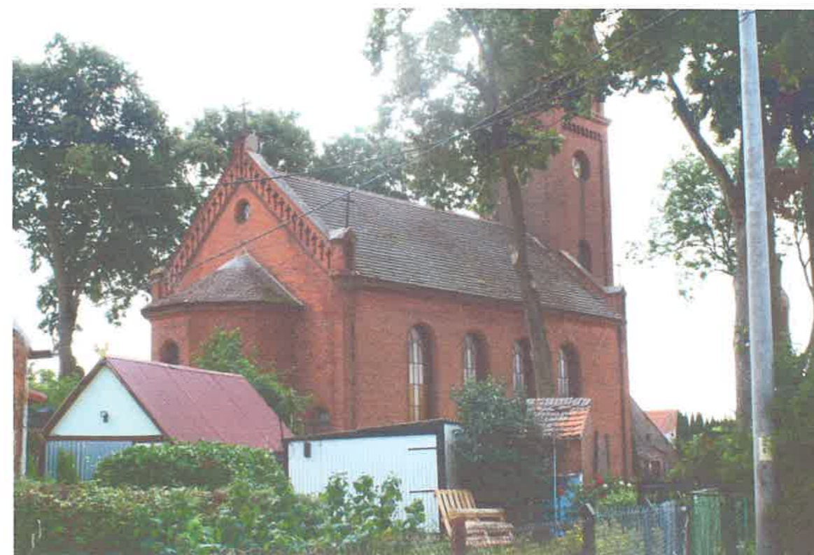
Fot. 3 Elewacja wschodnia i północna.
