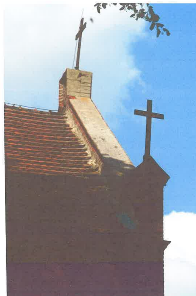
Fot. 6 Niestabilnie osadzony krzyż na wschodnim szczycie kościoła.
