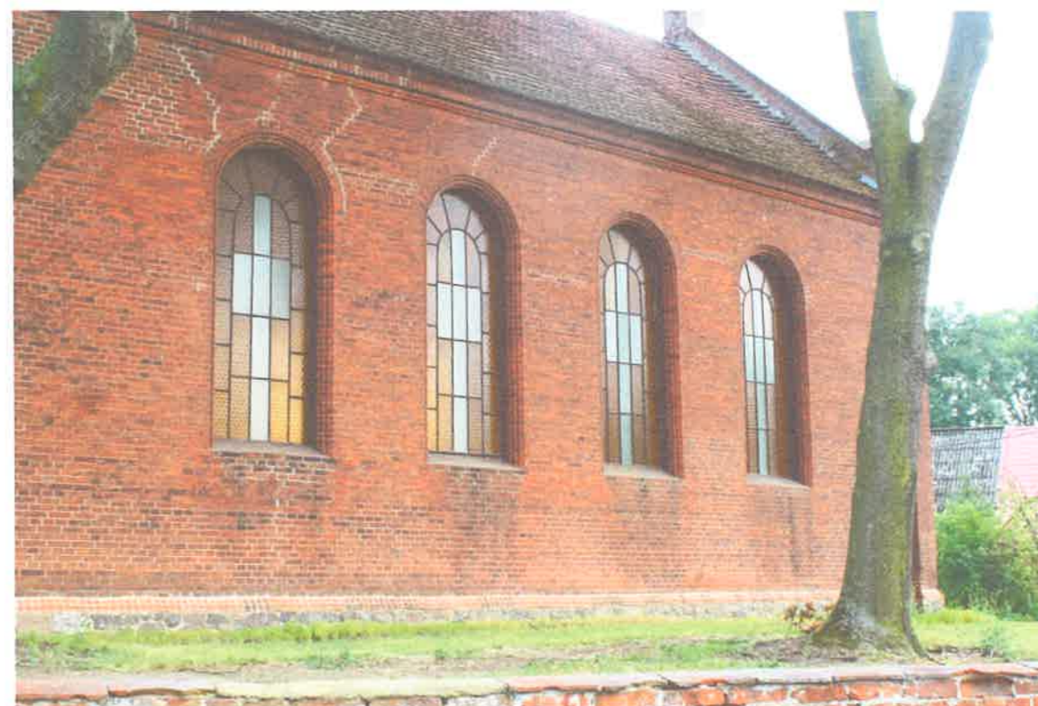
Fot. 2 Elewacja południowa.
