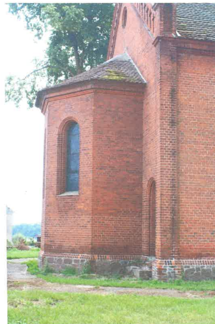
Fot. 4 Elewacja absydy.
