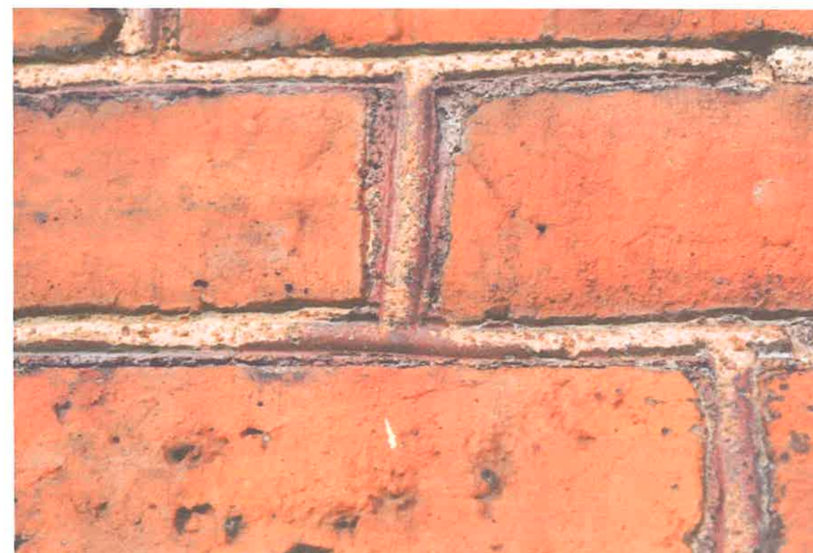
Fot. 18 Dobrze zachowana oryginalna spoina, z pozostałością czerwonej monochromii.
