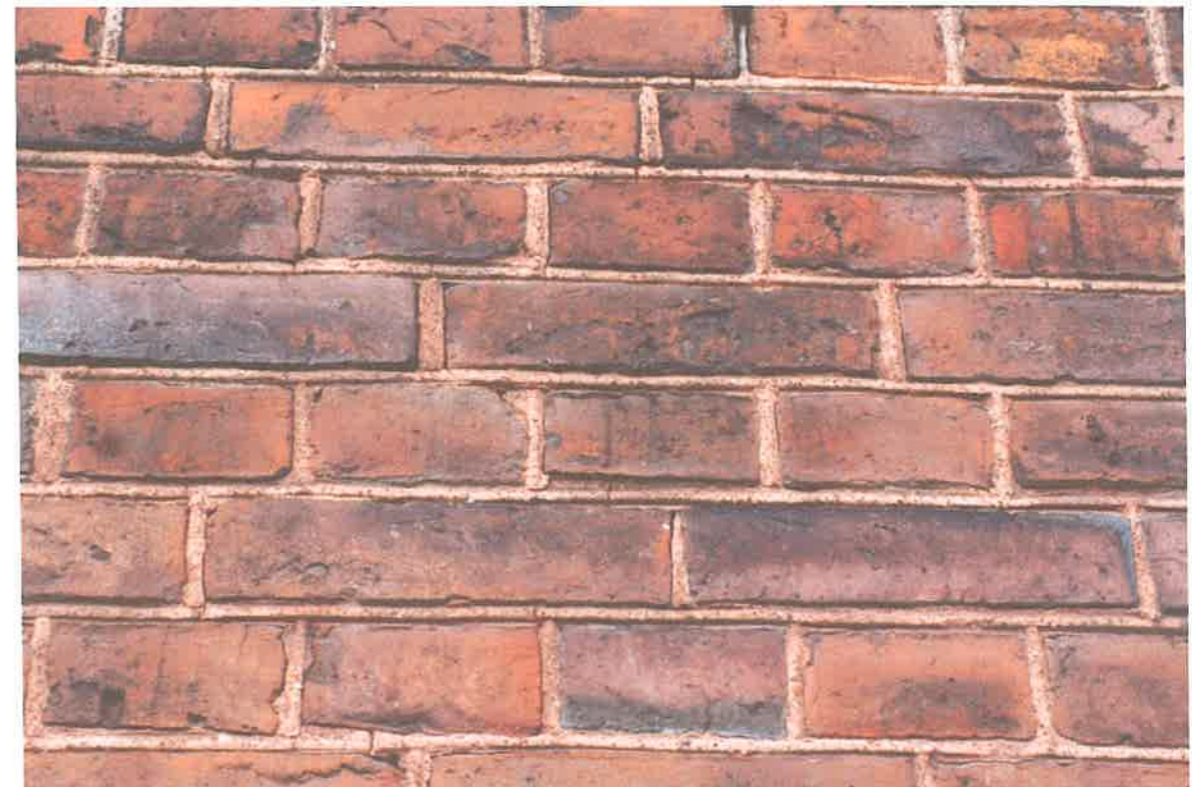
Fot. 16 Dobrze zachowana oryginalna spoina. Widoczne kształtowanie w formie wałka.
