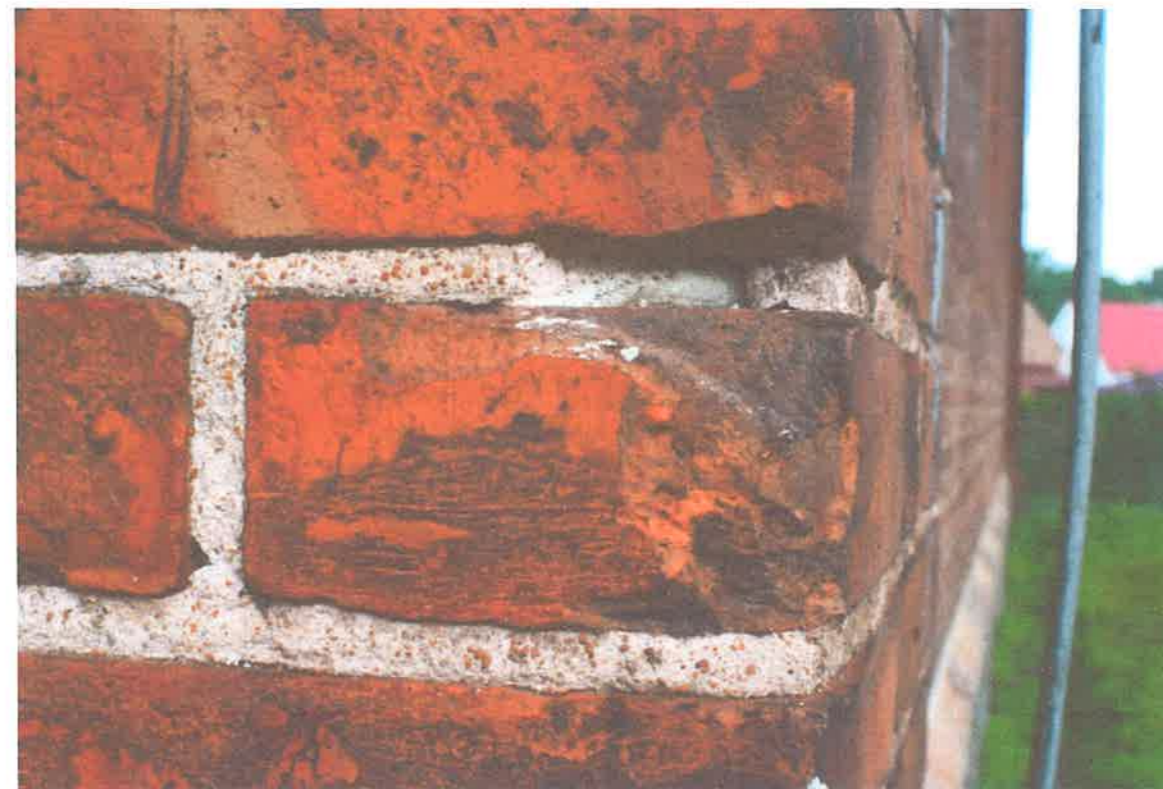
Fot. 17 Historyczna wapienna spoina z dodatkiem okruców i pyłu ceglanego, w głębi zaprawa murarska bez dodatków.
