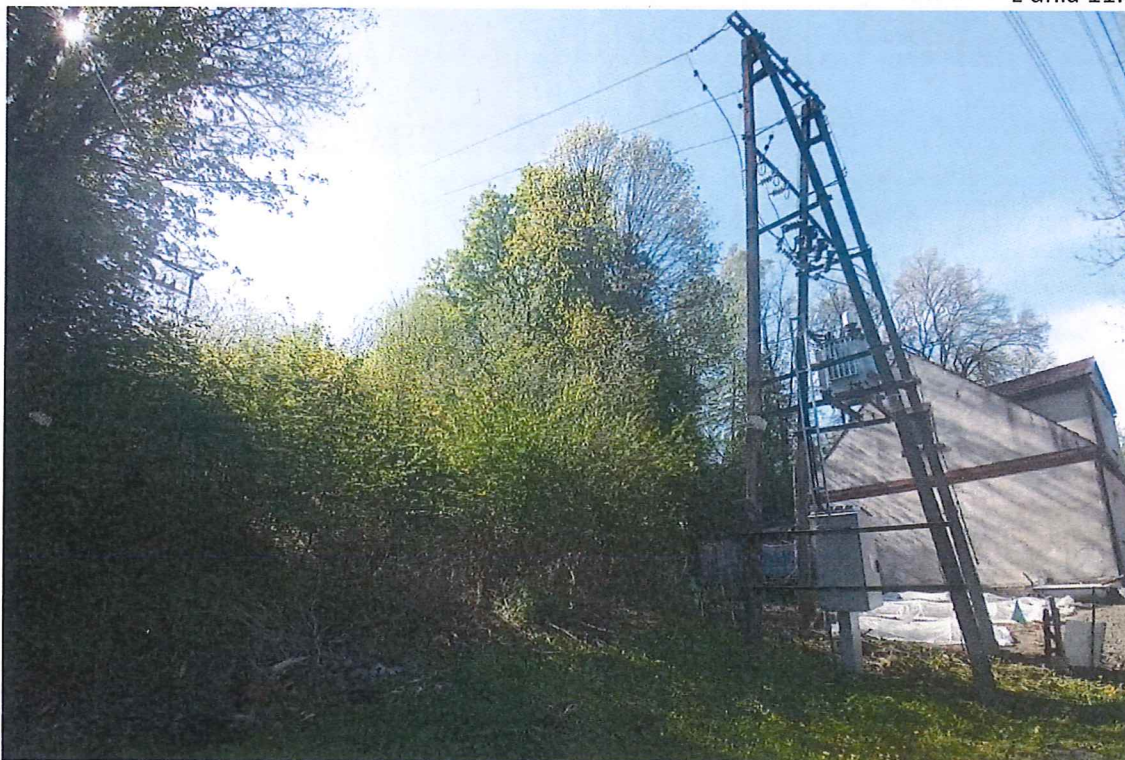
Fot. 3 Widok na czoło terenu, na którym występują ruchy masowe ziemi za budynkiem mieszkalnym – zadrzewiony i zakrzewiony – nie stwierdzono „gołym okiem” ruchów masowych ziemi.
