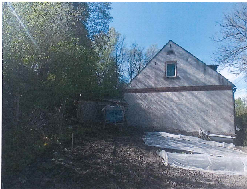
Fot. 5 Nie stwierdzono śladów spękań/uszkodzeń zewnętrznych ścian budynku mieszkalnego, spowodowanych ruchami masowymi ziemi.
