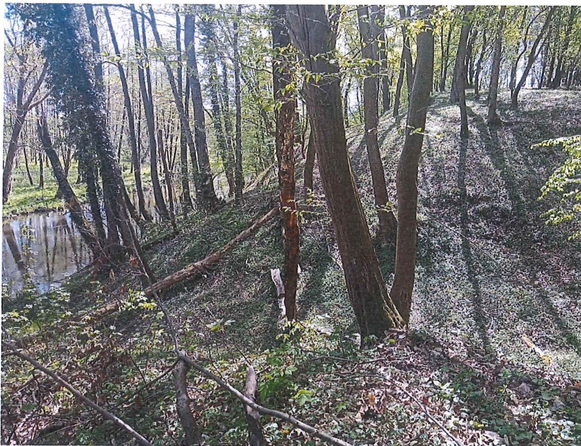
Fot. 6 Widok na teren, na którym występują ruchy masowe ziemi.
