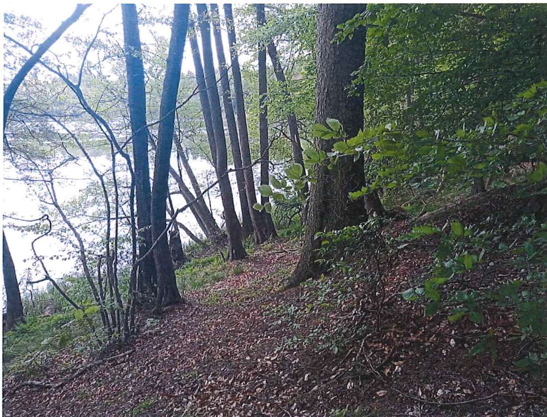
Fot. 4 Widok na osuwisko w kierunku południowo-wschodnim.
