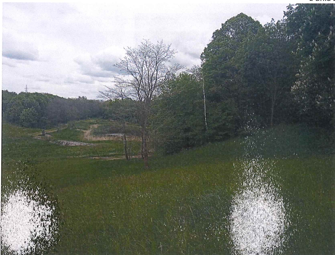
Fot. 2 Widok ogólny na osuwisko od strony zachodniej.
