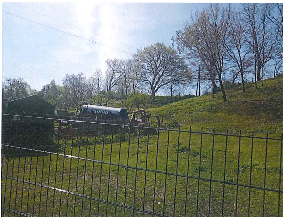
Fot. 7 Widok na północną stronę terenu zagrożonego ruchami masowymi ziemi (od strony obszaru zagospodarowanego) – brak śladów spętywania ziemi; widoczne pochylone drzewa.
