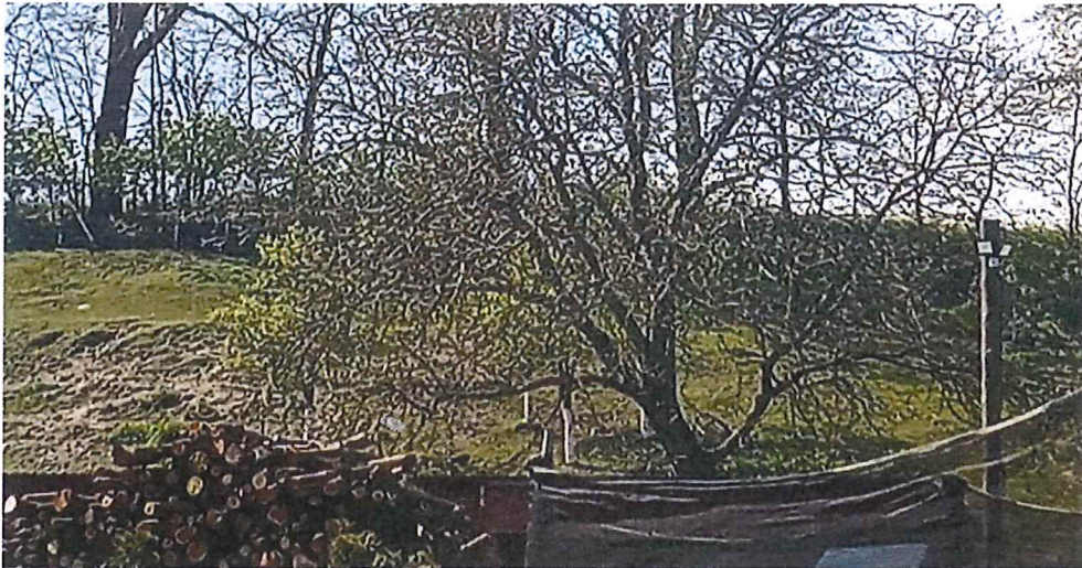
Fot. 5 Widok ogólny na północno-wschodnią stronę terenu zagrożonego ruchami masowymi ziemi (od strony obszaru zagospodarowanego) – widoczne „gołym okiem” ślady spełzywania ziemi.
