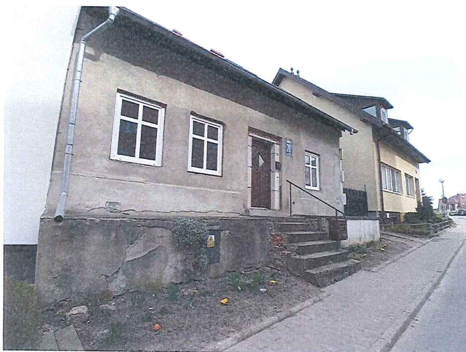
Fot. 25 Widok na frontową ścianę budynku na posesji przy ul. Górnej 20 (dz. nr 131/3 i 131/6 obr. 1-Barlinek) – nie stwierdzono przesunięć ziemi, spękań gruntu, uszkodzeń lub zniszczenia obiektu w wyniku ruchów masowych ziemi.
