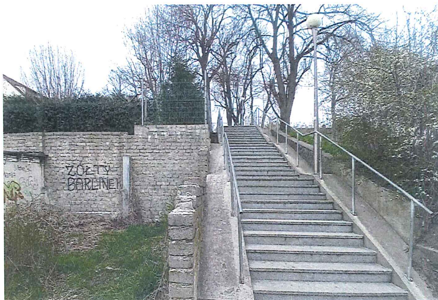
Fot. 23 Widok na schody na dz. nr 130 obr. 1-Barlinek – nie stwierdzono przesunięć, spękań; na murku oporowym po lewej stronie schodów (dz. nr 131/4 obr. 1-Barlinek) nie stwierdzono spękań/uszkodzeń w wyniku ruchu mas ziemnych.
