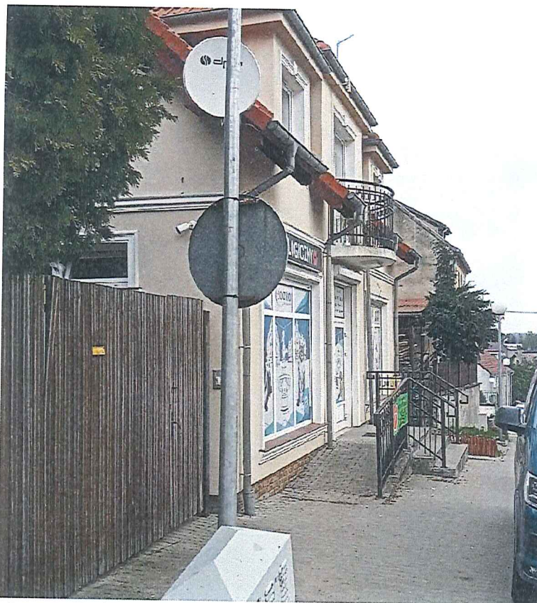
Fot. 21 Widok na budynek posesji ul. Górna (dz. nr 114/4 obr. 1-Barlinek) – nie stwierdzono spękań na budynku; nie stwierdzono pochylania się latarni ulicznych w wyniku ruchów masowych ziemi; brak spękań chodnika na całej długości.
