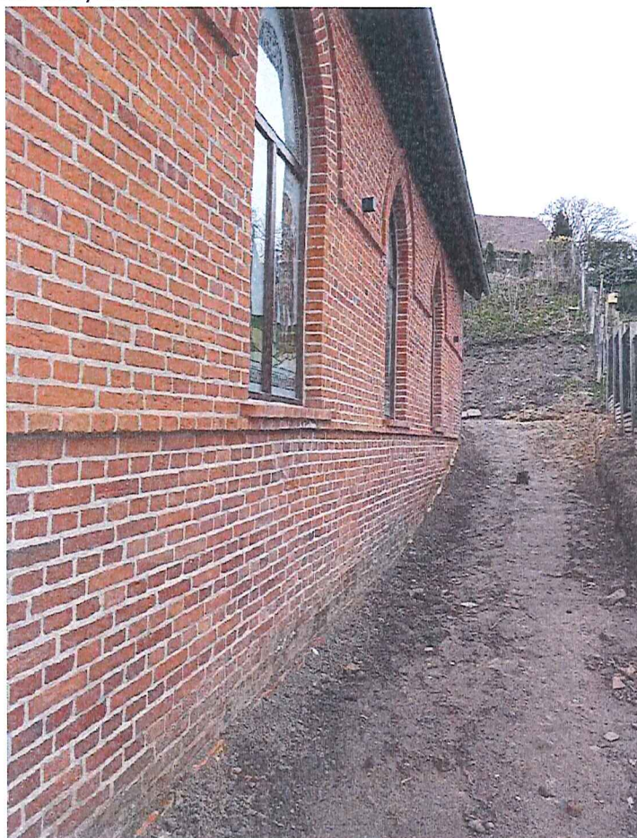
Fot. 14 i 15 Widok na budynek kościoła (dz. nr 115 obr. 1-Barlinek) – nie stwierdzono przesunięć/spękań/uszkodzeń budynku.
