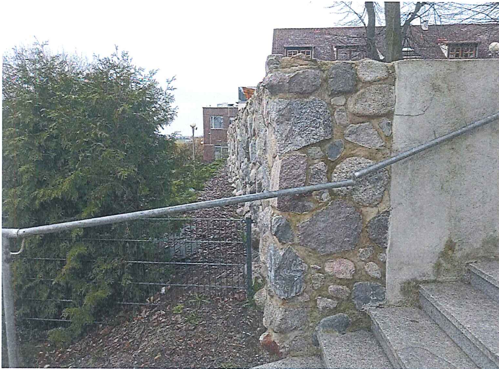
Fot. 11 i 12 Widok na murek oporowy i schody przy BOK(dz. nr 129/6 obr. Barlinek-1), prowadzące na ulicę Górną, położone na terenie zagrożonym ruchami masowymi ziemi – nie stwierdzono przesunięć/spękań/uszkodzeń.
