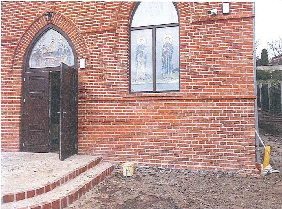
Fot. 14 i 15 Widok na budynek kościoła (dz. nr 115 obr. 1-Barlinek) – nie stwierdzono przesunięć/spękań/uszkodzeń budynku.
