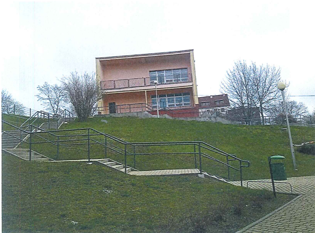
Fot. 2 Widok ogólny na wycinek terenu zagrożonego ruchami masowymi ziemi – ściana boczna budynku przedszkola publicznego (ul. Podwale 11); nie stwierdzono przesunięć ziemi, kostki, spękań gruntu.
