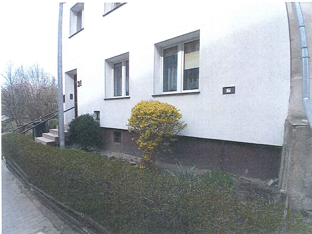
Fot. 26 Widok na frontową ścianę budynku na posesji przy ul. Górnej 21 (dz. nr 144 obr. 1-Barlinek) – nie stwierdzono przesunięć ziemi, spękań gruntu, uszkodzeń lub zniszczenia obiektu w wyniku ruchów masowych ziemi.
