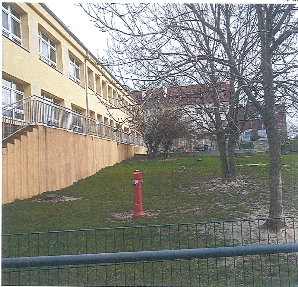
Fot. 4 Widok na ścianę tylną budynku przedszkola publicznego (ul. Podwale 11).
