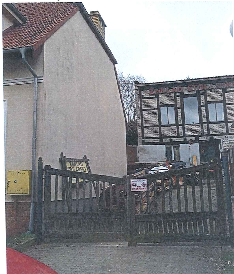
Fot. 20 Widok na boczną ścianę budynku posesji ul. Górna (dz. nr 114/4 obr. 1-Barlinek) – nie stwierdzono spękań na budynku; w głębi budynek zakładu stolarskiego (dz. nr 114/9 obr. 1-Barlinek) – nie stwierdzono spękań na budynku.
