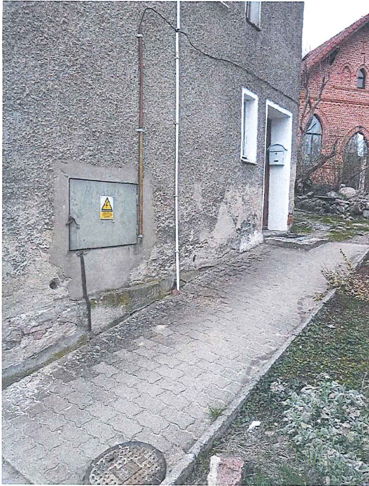
Fot. 18 Widok na boczną ścianę budynku posesji ul. Górna 8 (dz. nr 282 obr. 1-Barlinek) i frontową ścianę ul. Górna 10 (dz. nr 114/11 obr. 1-Barlinek)– nie stwierdzono spękań/uszkodzeń budynku/przesunięcia gruntu będących skutkiem ruchów masowych ziemi.
