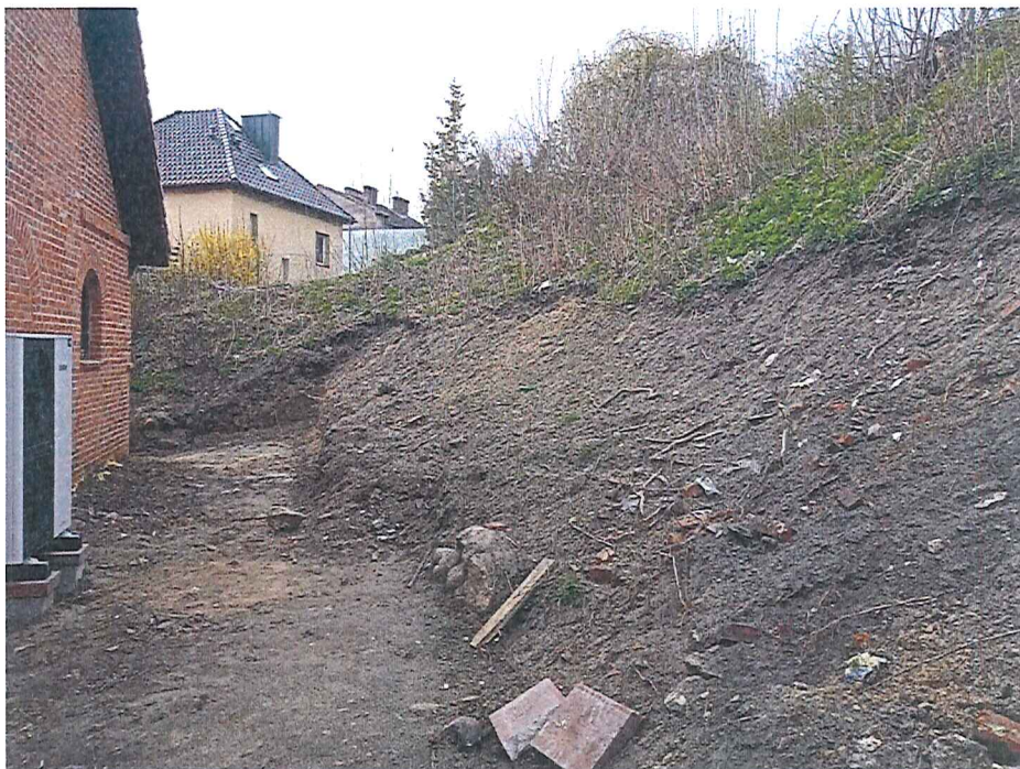
Fot. 16 Widok na tylną ścianę budynku kościoła i skarpe oczyszczoną w wyniku prac budowlanych z warstwy roślinności (dz. nr 115 obr. 1-Barlinek) – nie stwierdzono spękań/uszkodzeń budynku.
