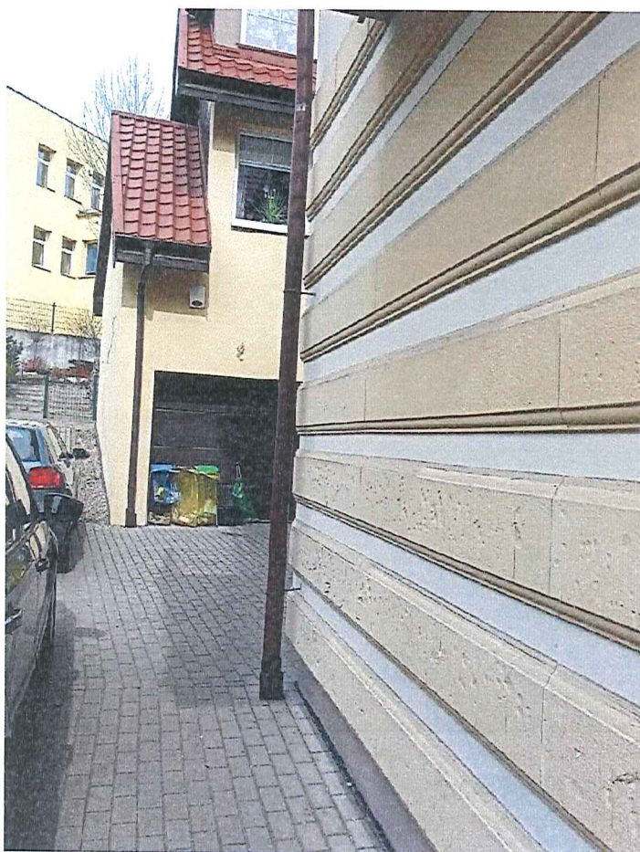
Fot. 29 Widok na boczną ścianę budynku na posesji ul. Górna 26 (dz. nr 155 obr. 1-Barlinek) – nie stwierdzono przesunięć ziemi, kostki, spękań gruntu, uszkodzeń, spękań lub niszczenia obiektów budowlanych w wyniku ruchów masowych ziemi; w głębi za siatką – przedszkole publiczne (ul. Podwale 13).
