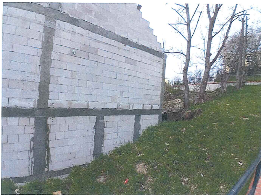
Fot. 28 Widok na boczną ścianę budynku na posesji na dz. nr 154 obr. 1-Barlinek – nie stwierdzono przesunięć ziemi, spękań gruntu, uszkodzeń, spękań lub niszczenia obiektu w wyniku ruchów masowych ziemi.
