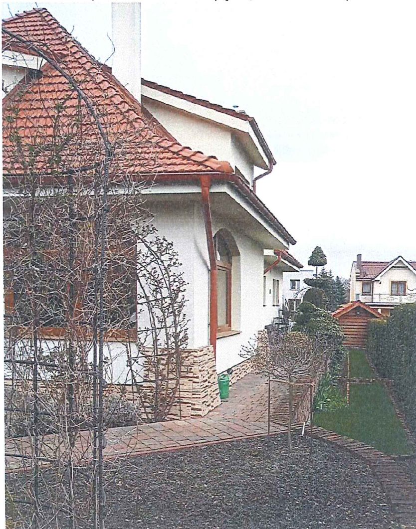
Fot. 17 Widok na pd ścianę budynku posesji nr 3 (dz. nr 114/15 obr. 1-Barlinek) (od strony kościoła) – nie stwierdzono spękań/uszkodzeń budynku/przesunięcia gruntu.
