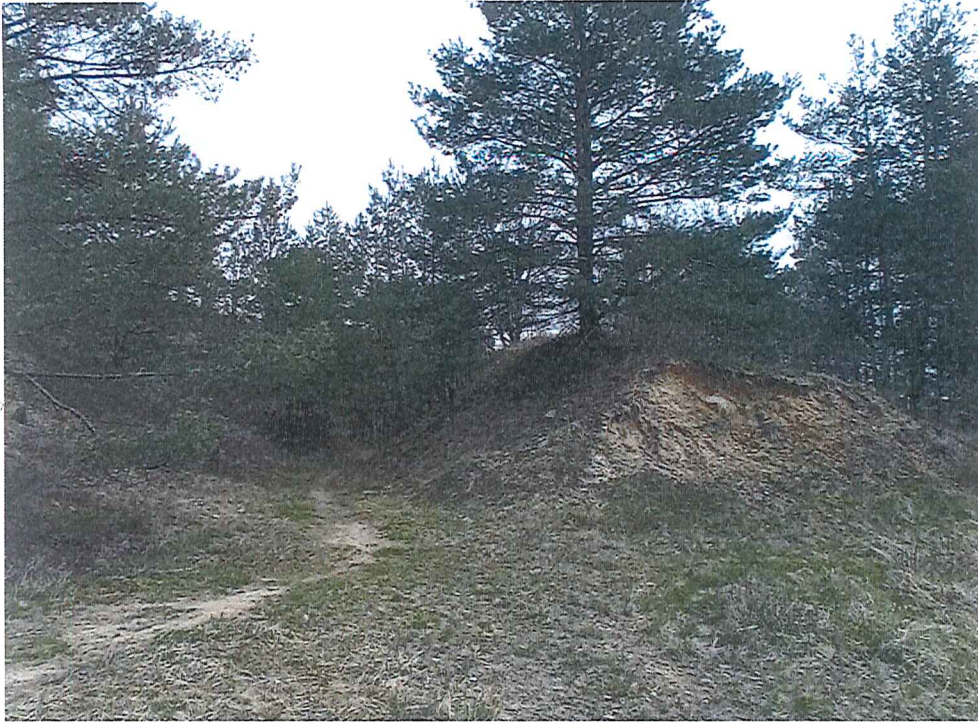
Fot. 5 i 6 Widok ogólny na wycinek części wschodniej terenu, na którym występują ruchy masowe ziemi – widoczne osunięcia ziemi ze skarp starego wyrobiska; skarpy niezabezpieczone.
