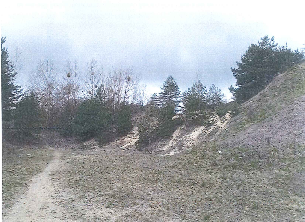
Fot. 8 Widok ogólny na wycinek części zachodniej terenu, na którym występują ruchy masowe ziemi – widoczne osunięcia ziemi ze skarp starego wyrobiska; za szpalerem drzew – ul. Kombatantów; skarpy niezabezpieczone, nieustabilizowane.
