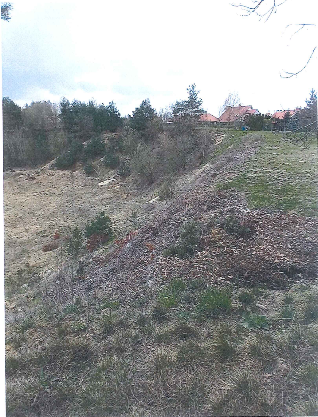
Fot. 10 Widok ogólny na część północno-zachodnią terenu zagrożonego ruchami masowymi ziemi – skarpy starego wyrobiska od strony ul. Sosnowej (w oddali widoczny rząd domów jednorodzinnych przy ww. ulicy); brak widocznych osunięć ziemi z tej części skarpy; skarpy niezabezpieczone, częściowo zadarnione.
