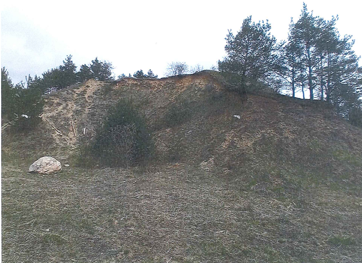
Fot. 7 Widok ogólny na wycinek części wschodniej terenu, na którym występują ruchy masowe ziemi – widoczne osunięcia ziemi ze skarp starego wyrobiska; skarpy niezabezpieczone, nieustabilizowane.
