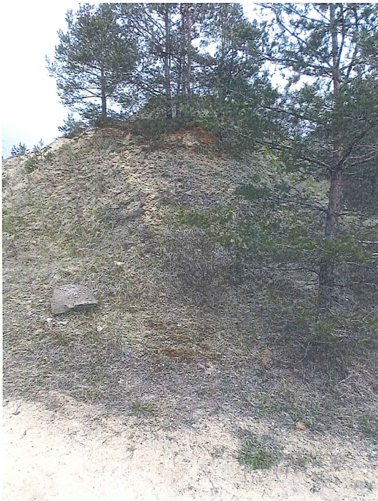
Fot. 5 i 6 Widok ogólny na wycinek części wschodniej terenu, na którym występują ruchy masowe ziemi – widoczne osunięcia ziemi ze skarp starego wyrobiska; skarpy niezabezpieczone.
