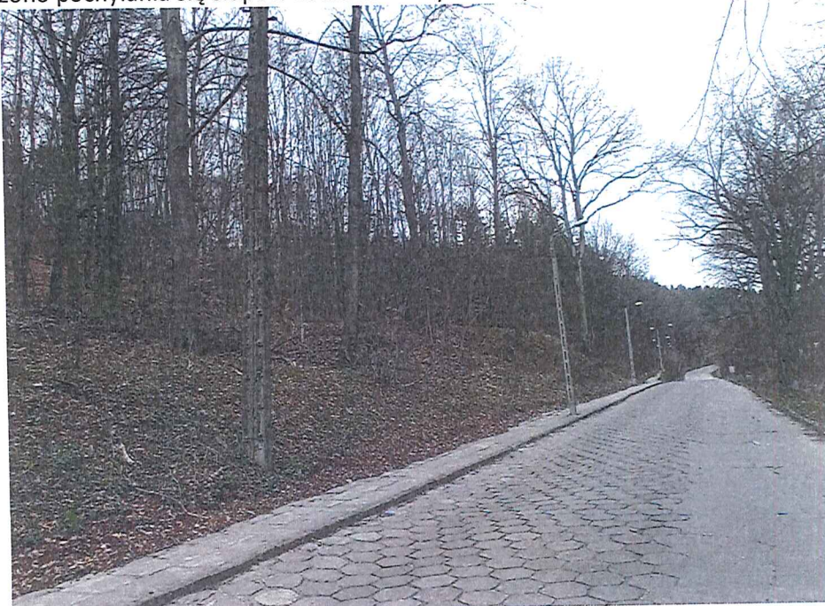
Fot. 15i 16 Widok na drogę powiatową w stronę zakładu HACON (ul. Fabryczna); po lewej stronie przecina drogę; nie stwierdzono pochylania się słupów oświetleniowych w wyniku ruchów masowych ziemi.
