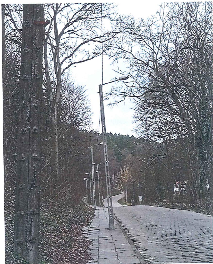
Fot. 15i 16 Widok na drogę powiatową w stronę zakładu HACON (ul. Fabryczna); po lewej stronie przecina drogę; nie stwierdzono pochylania się słupów oświetleniowych w wyniku ruchów masowych ziemi.
