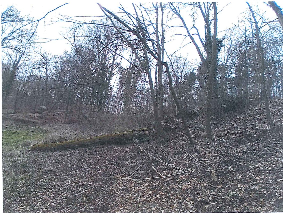
Fot. 11 Widok na zbocze TZOMZ poniżej drogi; drzewa nieco przechylone; nie stwierdzono osunięć ziemi, obrywów, spękań gruntu; roślinności wodolubnej na zboczu.
