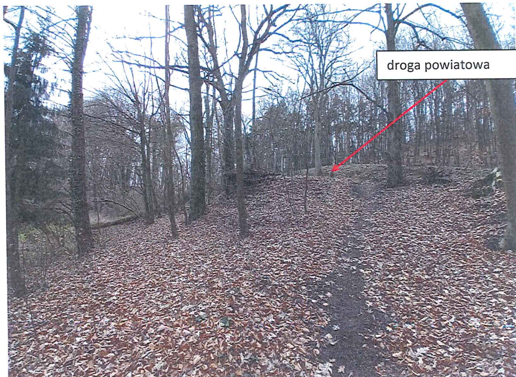
Fot. 9 Widok na zbocze na TZOMZ; w oddali droga powiatowa przebiegająca w części zbocza po wyciętej w nim półce; poniżej drogi zestromienie.
