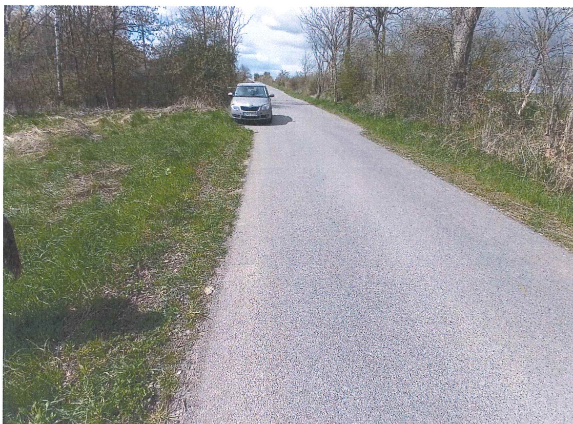
Fot. 9 Widok na drogę gminną Laskówko-Równo (dz. nr 208 obr. Równo gm. Barlinek); po lewej stronie zdjęcia teren zagrożony osuwaniem się mas ziemnych – tu: bardzo stroma skarpa widoczna na Fot. 8.
