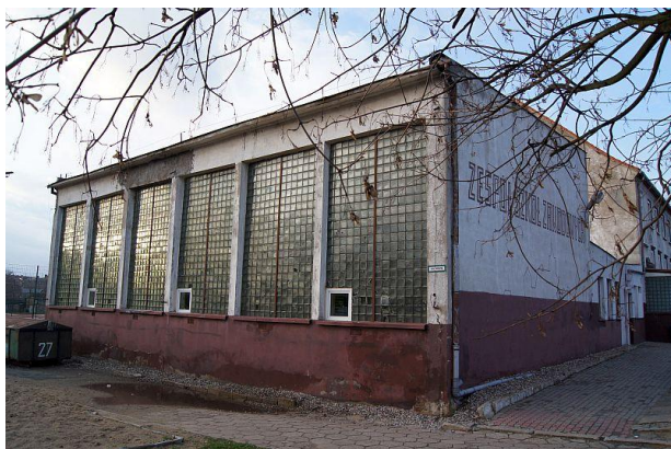
Sala gimnastyczna- przed termomodernizacją.
