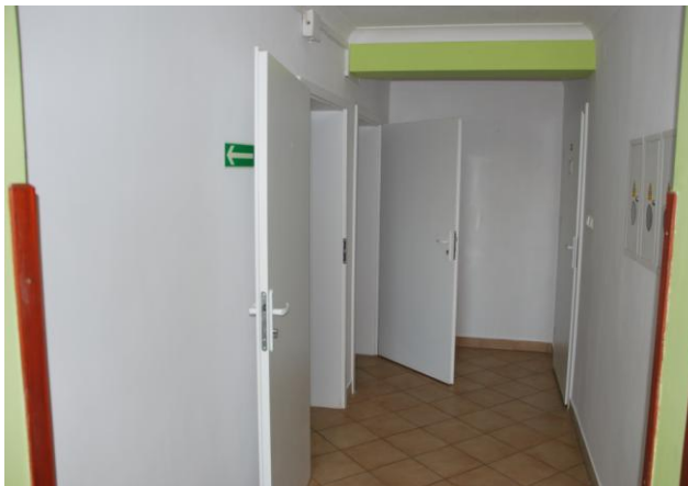
Poszerzenie i przystosowanie dla potrzeb osób niepełnosprawnych na dziale III otworów drzwiowych
